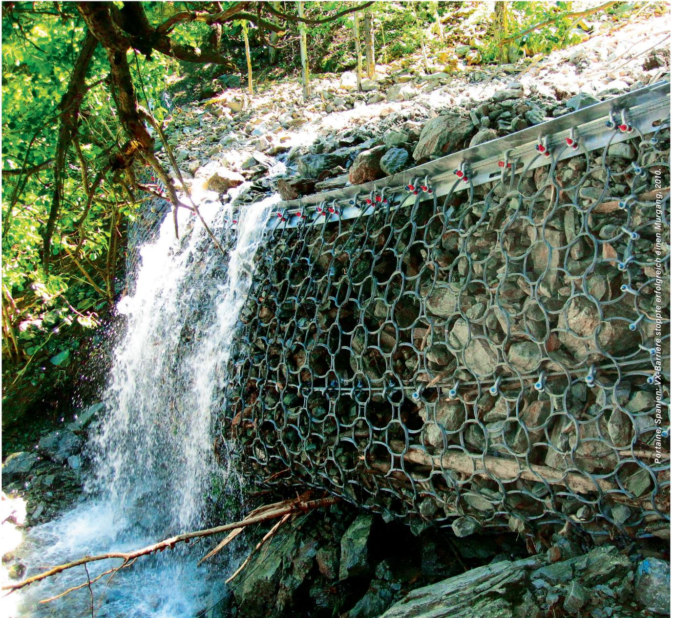
Diese flexiblen Ringnetzbarrieren aus hochfestem Stahldraht schützen auf innovative und effiziente Weise Mensch und Infrastruktur. Geobrigg-Systeme zeichnen sich dadurch aus, dass sie einfach aufgebaut, schnell installiert und unauffällig in der Natur sind.
