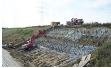
Böschungssicherung
