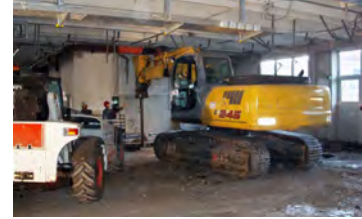
Nachgründungen mit beschränkter Arbeitshöhe
