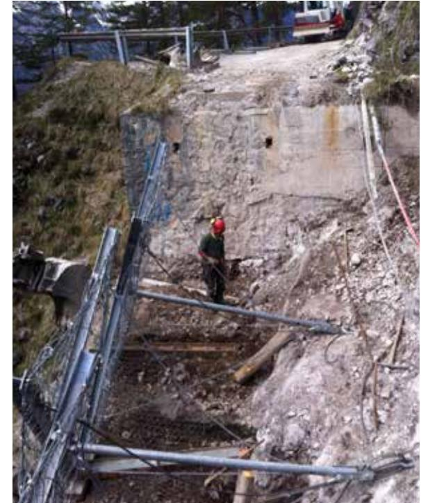
**ERDOX® Terra** wird zu Hang- Bachverbauungen und lokalen Phänomenen der Instabilität verwendet, auch in extremsten technischen und strukturellen Einsätzen. Es wird auch im Uferbau als Erosionsschutz und in Rinnen mit Debris Flow eingesetzt.
