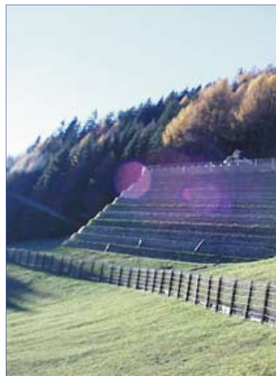
Die im Ahrntal (Italien) hergestellte Aufschüttung gegen Steinschlag hat eine Länge von 165 Metern. Die Höhe auf Talseite reicht bis 21 Metern und mit einem Neigungswinkel von 70° (darüber: ein schematischer Querschnitt der Aufschüttung, mit freundlicher Genehmigung des Ingenieurbüros Von Pföstl & Helfer).
