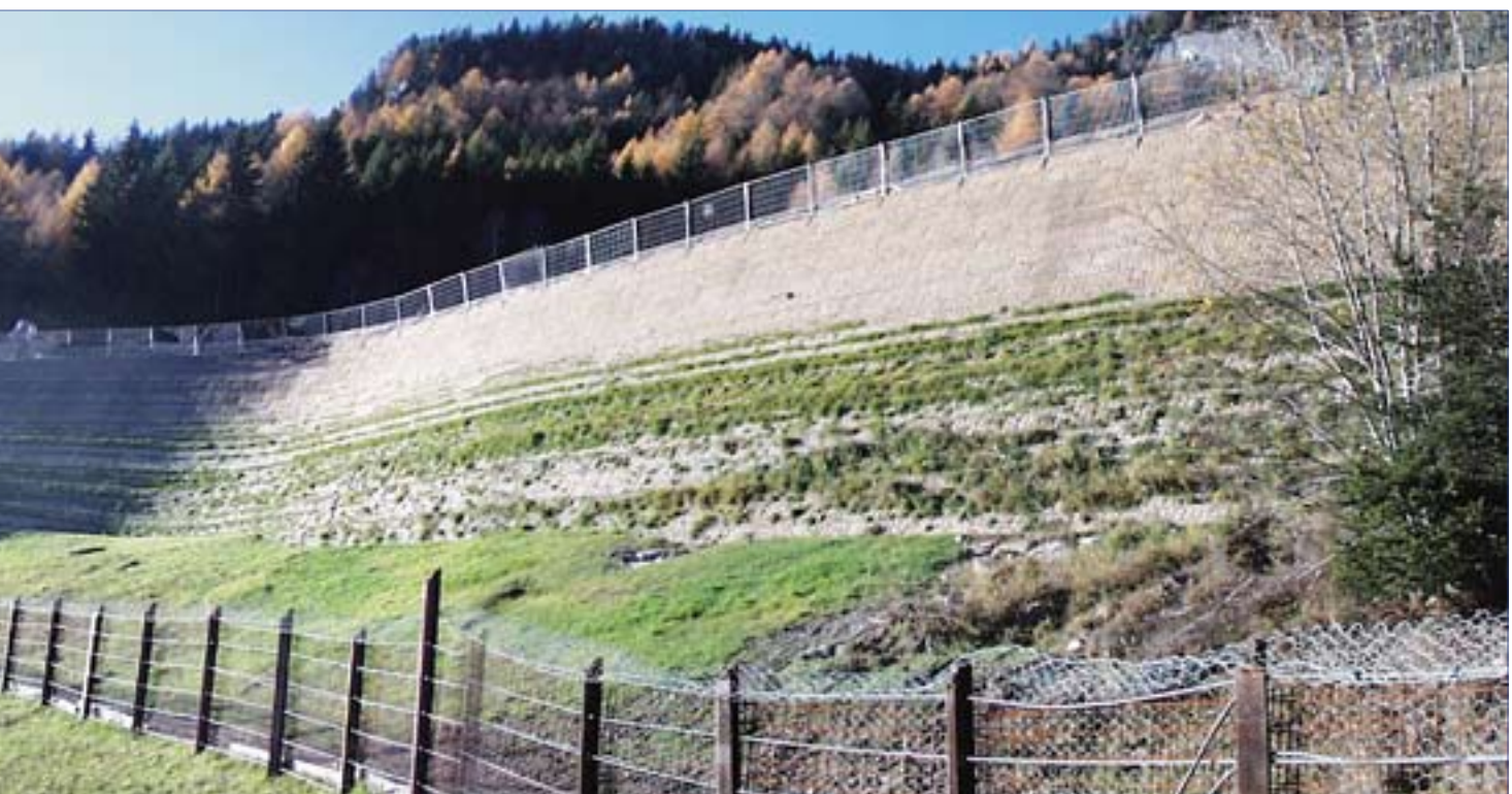
Foto 2: Geringe Auswölbung an der Tal-Frontseite der Aufschüttung.
