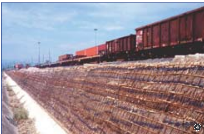
Foto 4: Eisenbahn-Stützaufschüttung für neues Schienengleis (Jesi, Italien).
