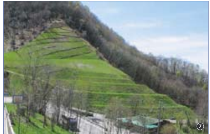
Foto 8: Schallschutzwände aus bewehrter Erde am Autobahnabschnitt Bologna-Casalecchio.
