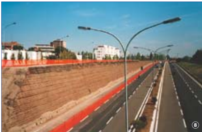
Foto 1 und Abbildung 6: Bei den Arbeiten für die Sanierung des Erdbebens oberhalb des Rastplatzes Grontone an der Autobahn der Cisa waren umfangreiche und sorgfältige Arbeiten zur Dränung des Wassers, eine Neuprofilierung der Hänge mit einer Geometrie, die die Hangstabilität sicherstellte, die Sicherung der Hänge mit Metallnetz
