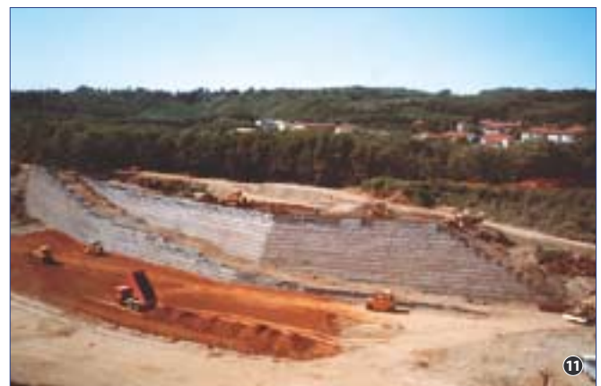
Foto 10: A32 Autobahnabschnitt Savoulx-Bardonecchia: Außerordentliche Wartungsarbeiten für die Verbesserung der Sicherheitsbedingungen und Bau der vierten Fahrspur.
