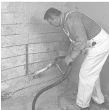
Der Maschinenputz wird aufgebracht.
