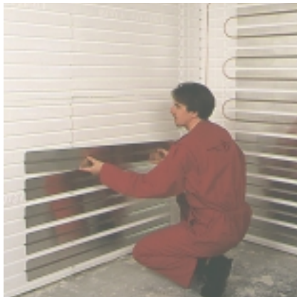
Nach Montage der siccus Verlegeplatten werden die Wärmeleitlamellen aus Alu eingelegt.
